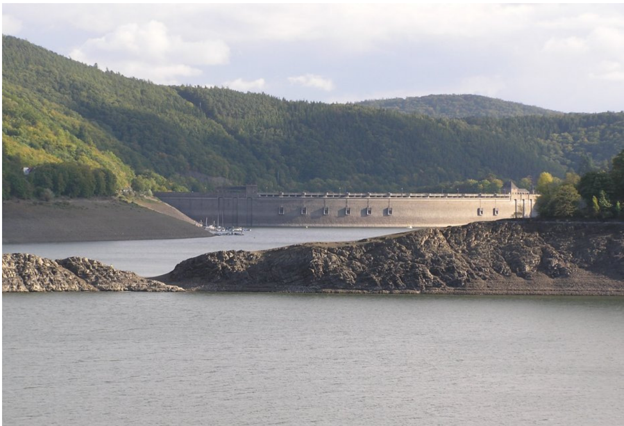
Abb.: Edertalsperre 2003, Aufnahme WSA Hann. Münden
